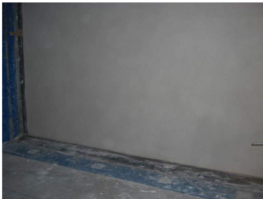
Muro con intonaco lato camera ricevente
