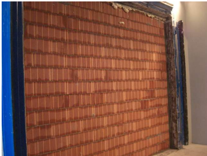
Muro lato camera emittente
