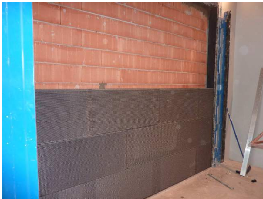
Realizzazione sistema TERMOK8® muro lato camera emittente
