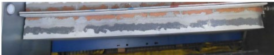
Figura 2. Riproduzione fotografica del pannello "TermoK8 Modular Big" all'interno della cella climatica, immediatamente prima dell'inizio dei cicli Heat-Rain.
